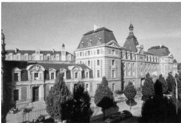
▲法国雷恩市左拉中学大楼。
